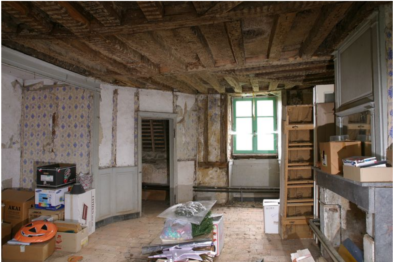
Etage de comble, pièce nord : l'alcôve et le mur ouest.
