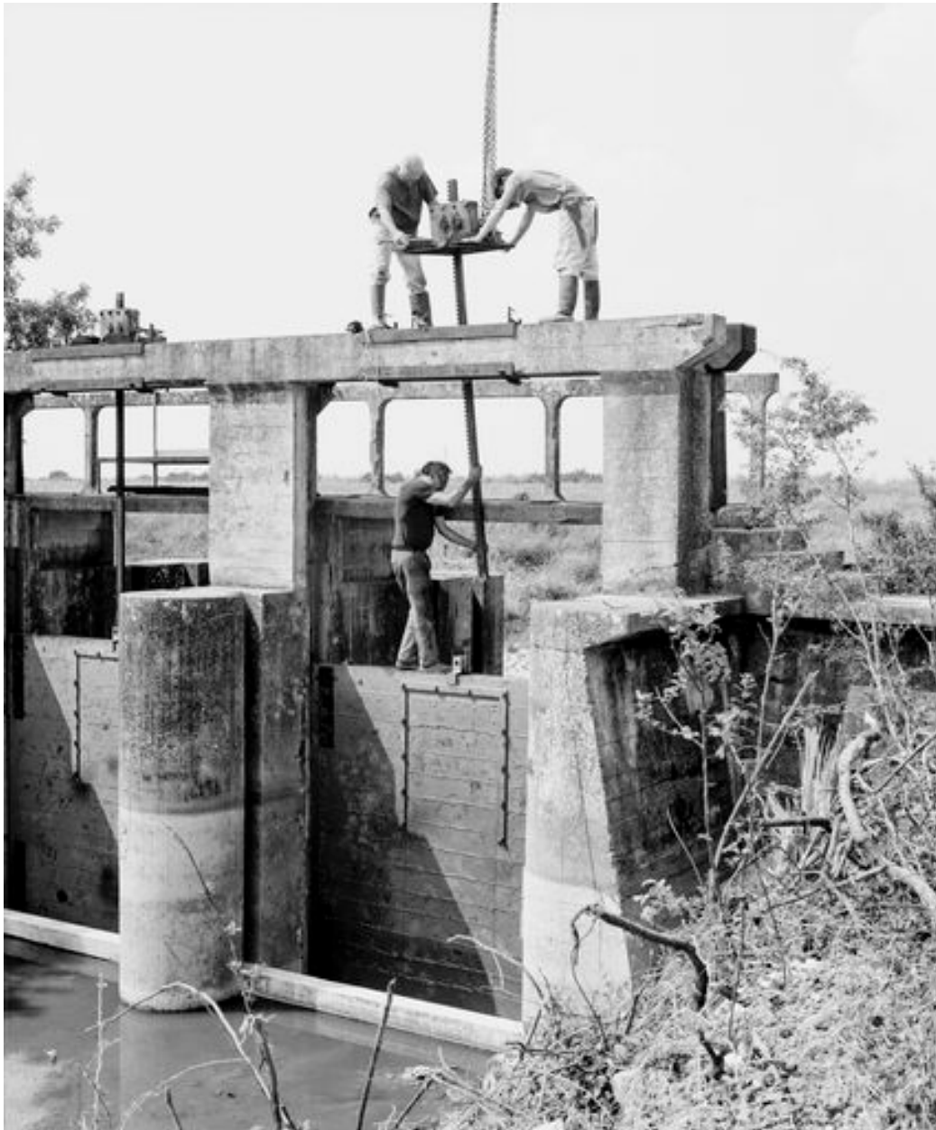
Remise en place de la crémaillère d'une porte-vanne, en 1999.
