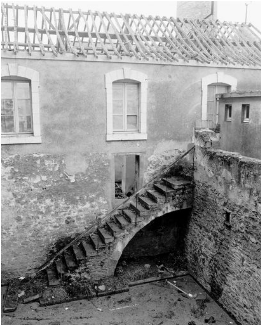
Bassin postérieur nord-ouest et face nord-est du bâtiment C.
