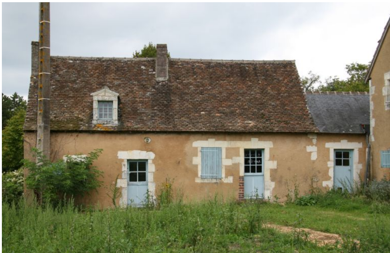
Maison n° 3, aile est : façade ouest.
