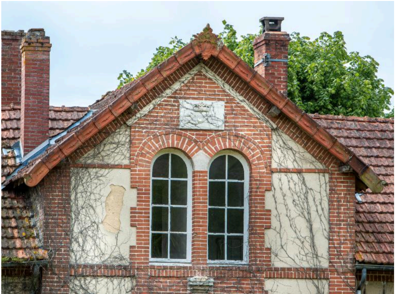
Un détail du logement.
