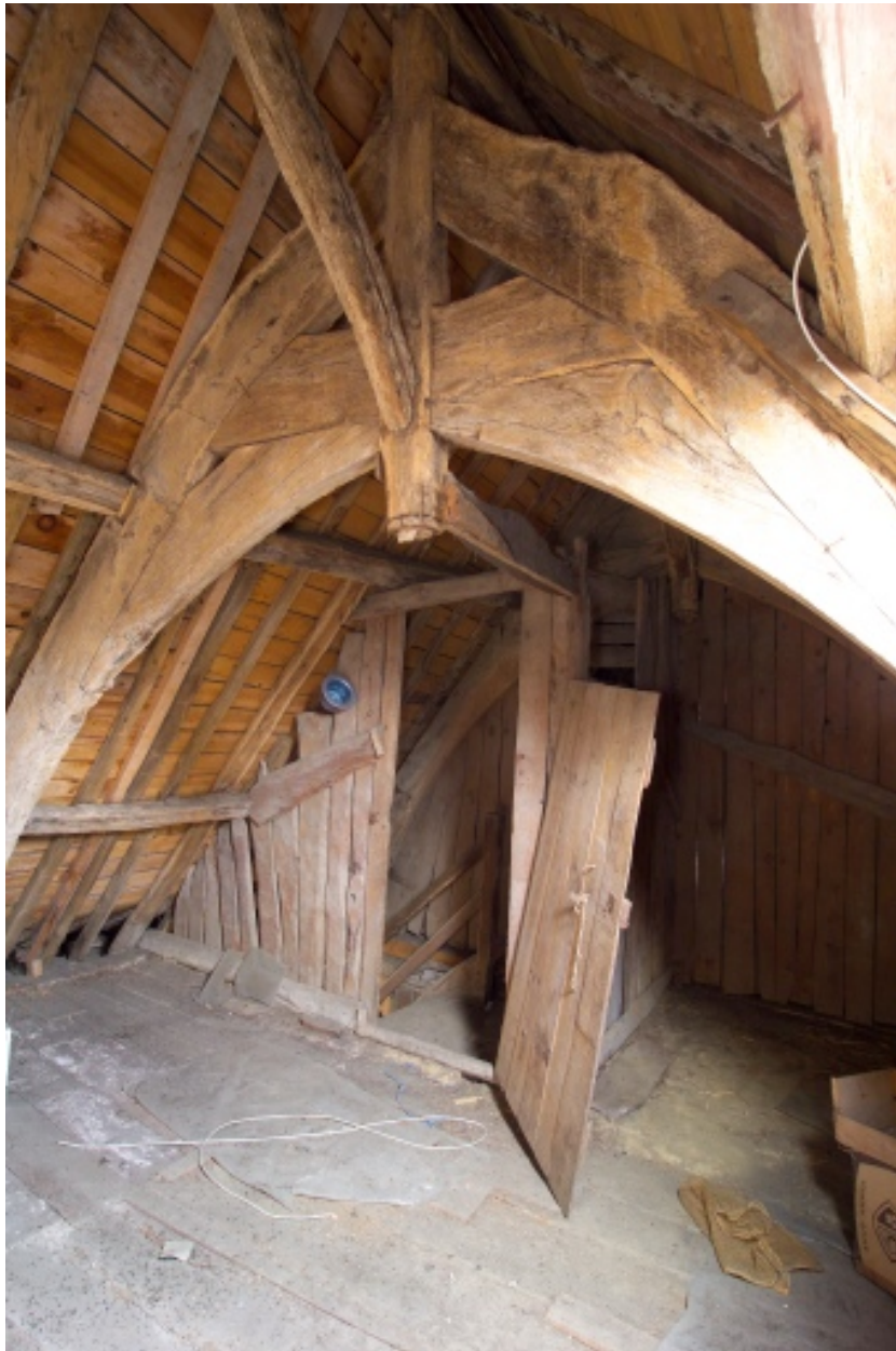
Ferme de charpente et cloison légère du comble.
