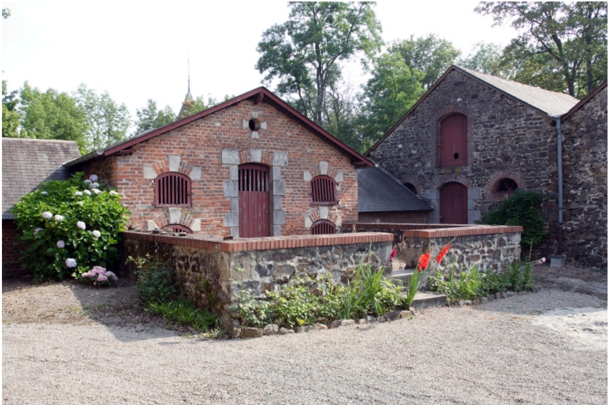
Les bâtiments nord et l'étable est.
