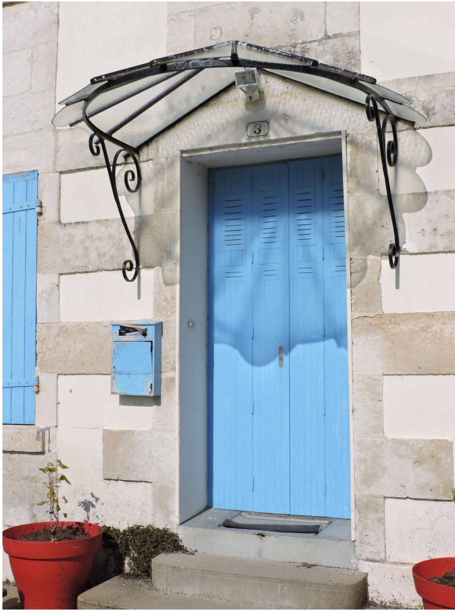
La porte et sa marquise.
