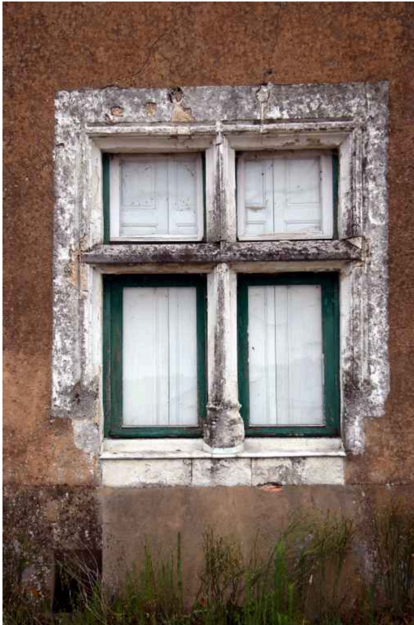
Croisée droite au rez-de-chaussée.
