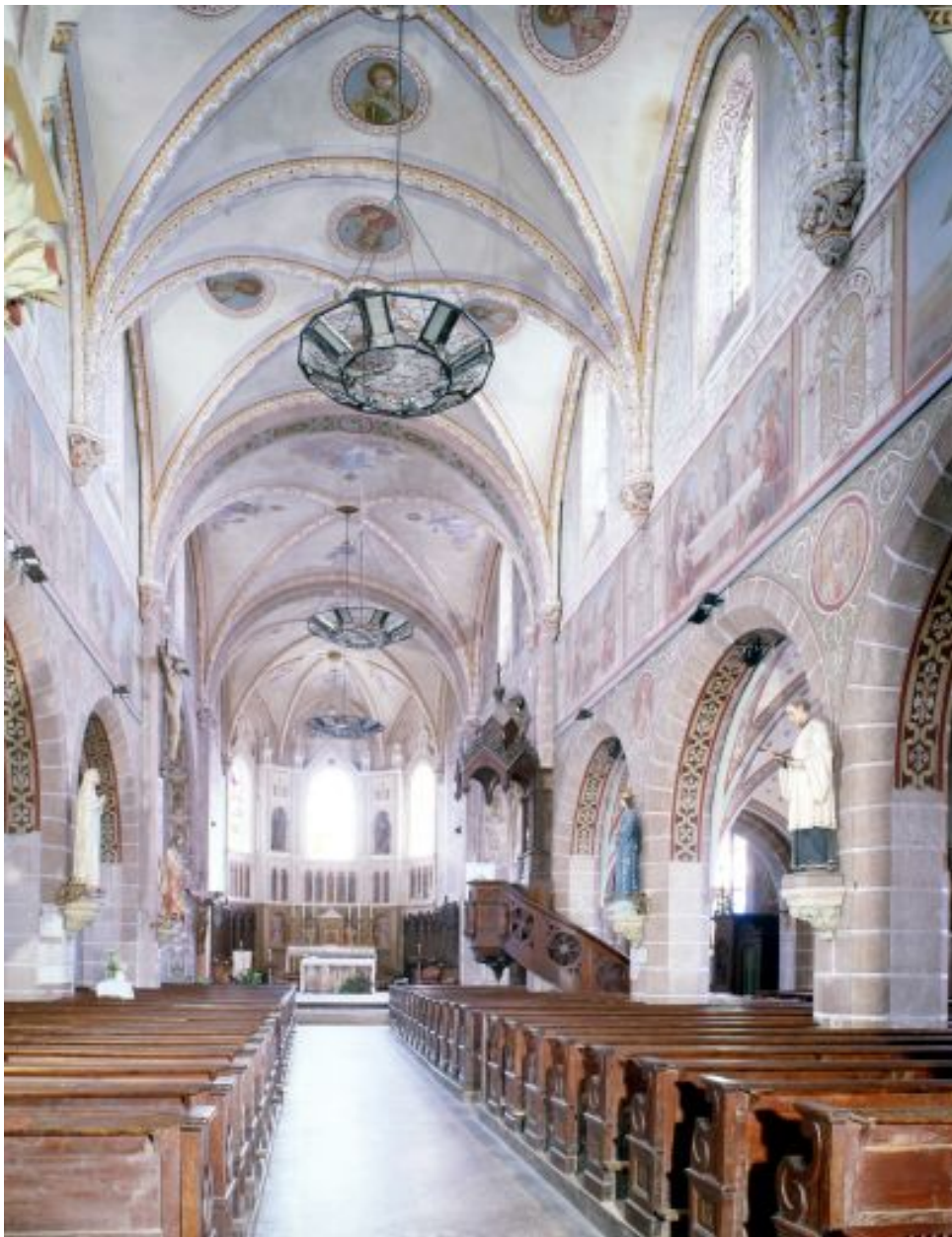
Vue d'ensemble vers l'est.
