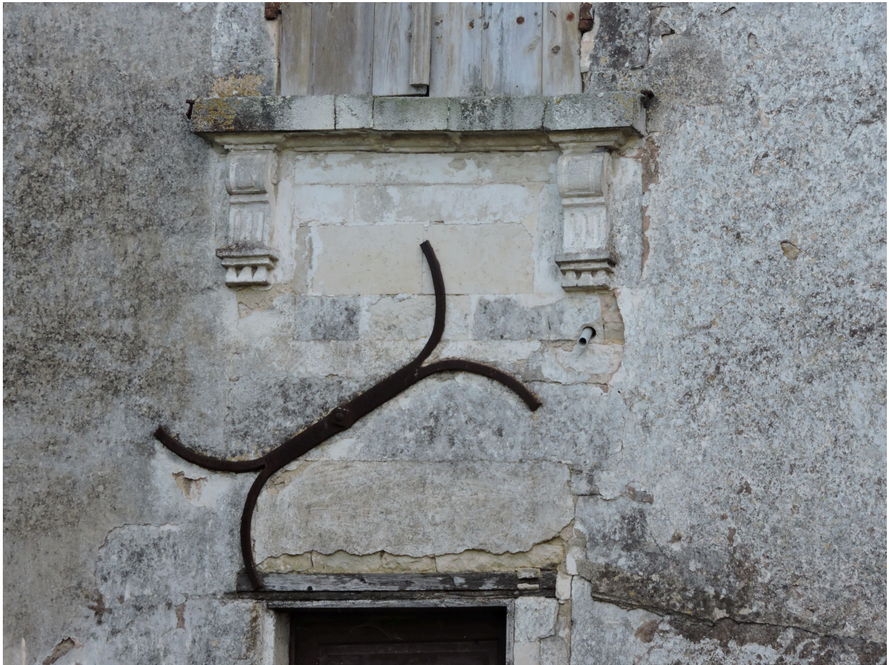
Appui de fenêtre avec consoles sur la façade nord de la maison.
