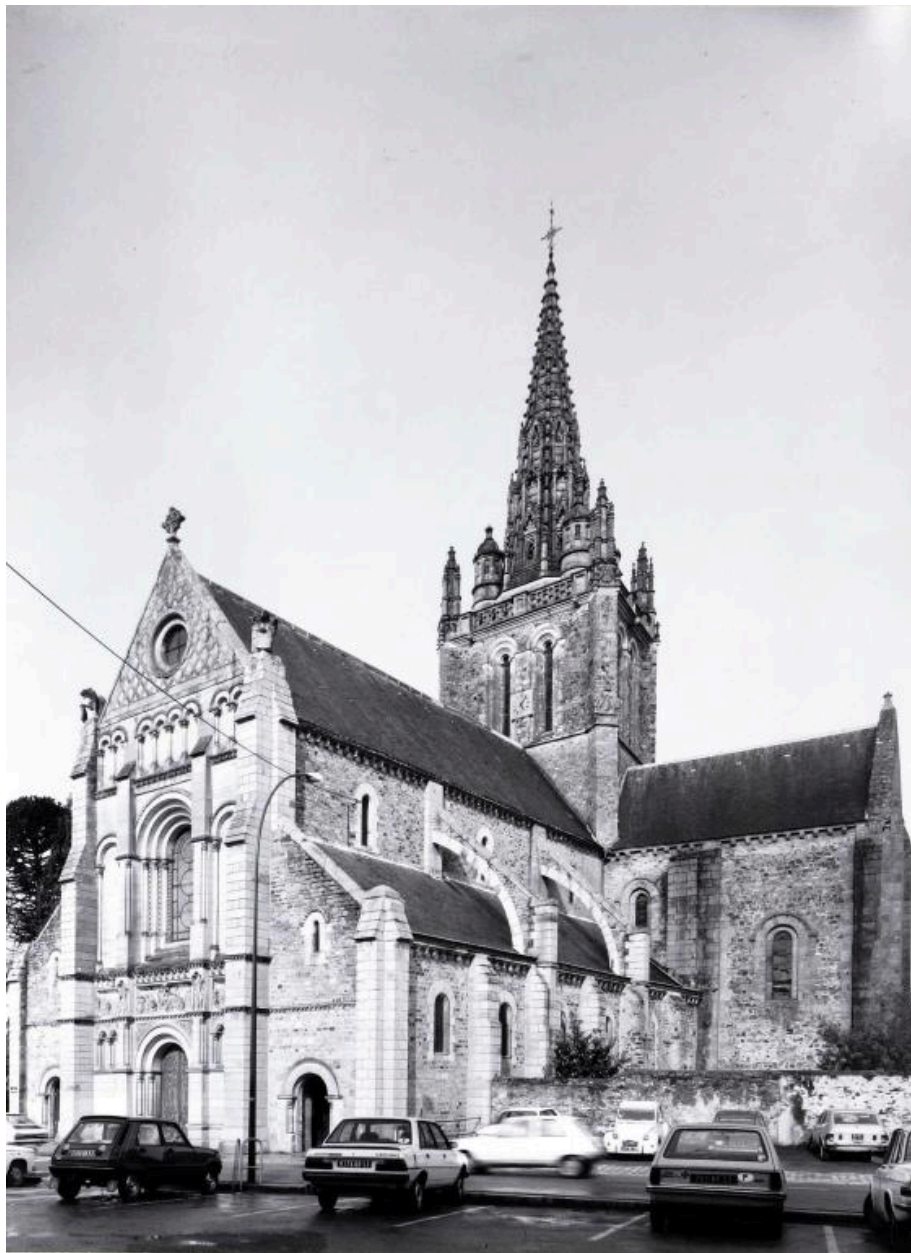
Eglise, vue d'ensemble depuis le sud-ouest.
