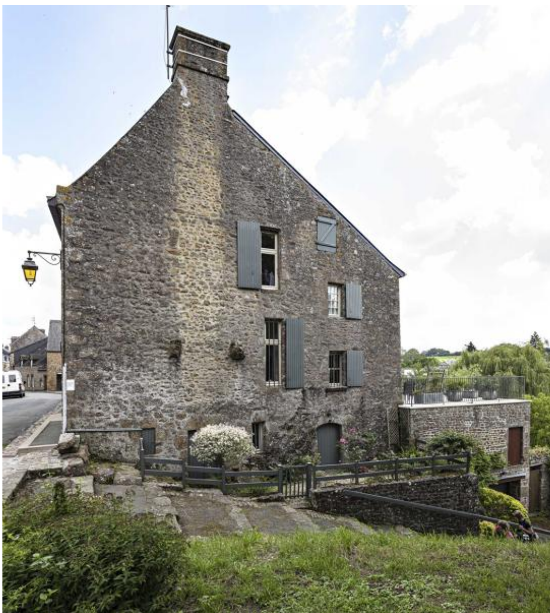
Mur-pignon du 20 rue du Château.
