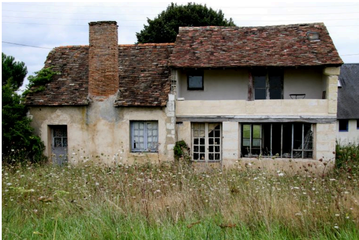
Maison n° 2 : façade postérieure.
