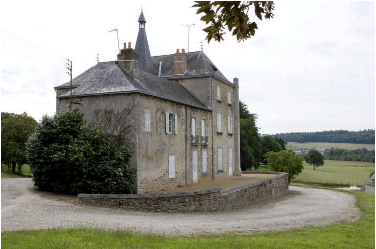
Le château : aile vue depuis le le nord-ouest.
