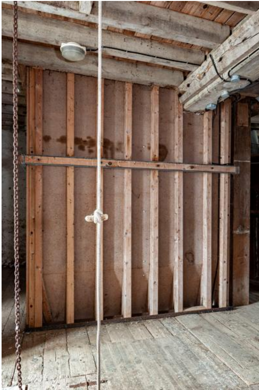
Deuxième étage, partie sud-ouest : la chambre à farine installée en 1981, vue depuis l'est.
