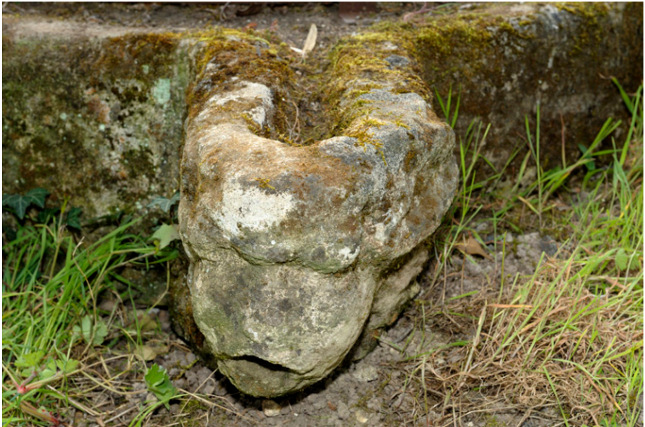
Ancien puits : détail de la gargouille (3).
