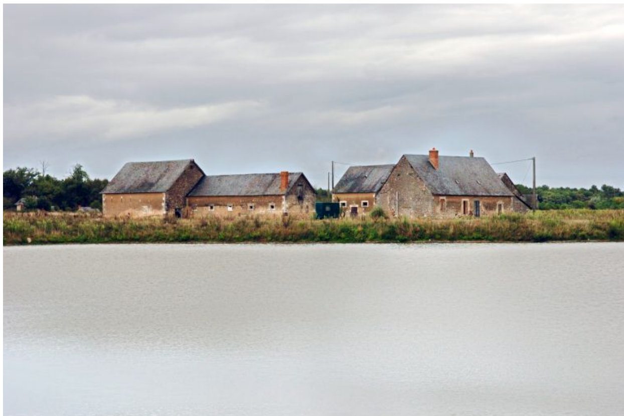
Vue d'ensemble prise du sud (carrières Point P).
