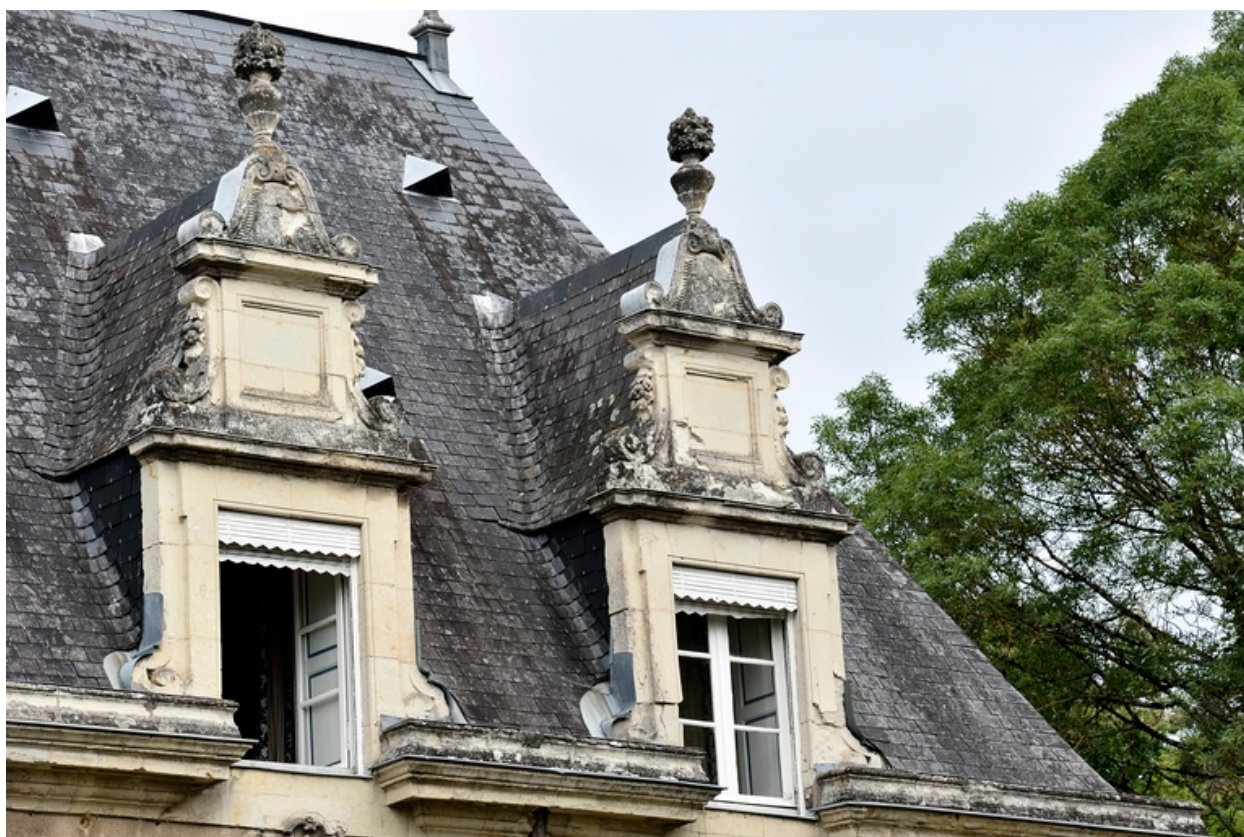
Détails des lucarnes de la façade est.
