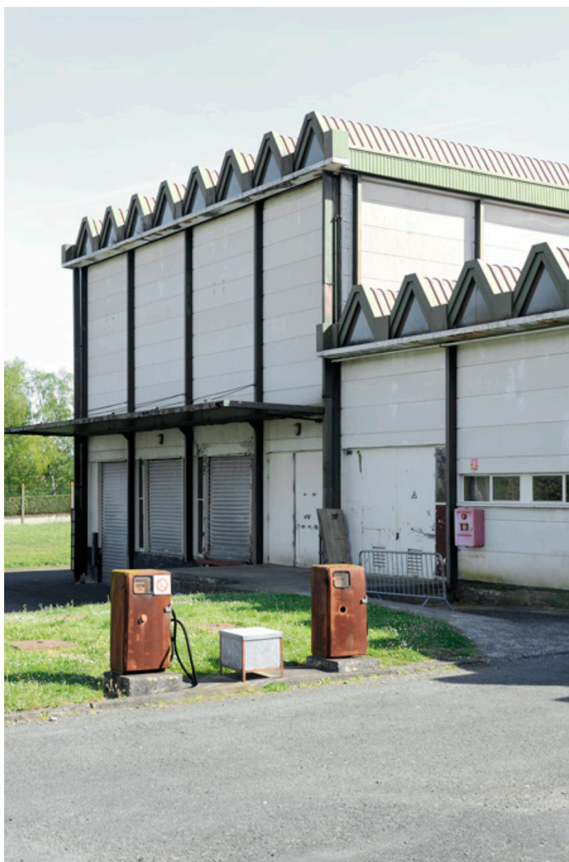
Usine SACAIR : façade ouest.
