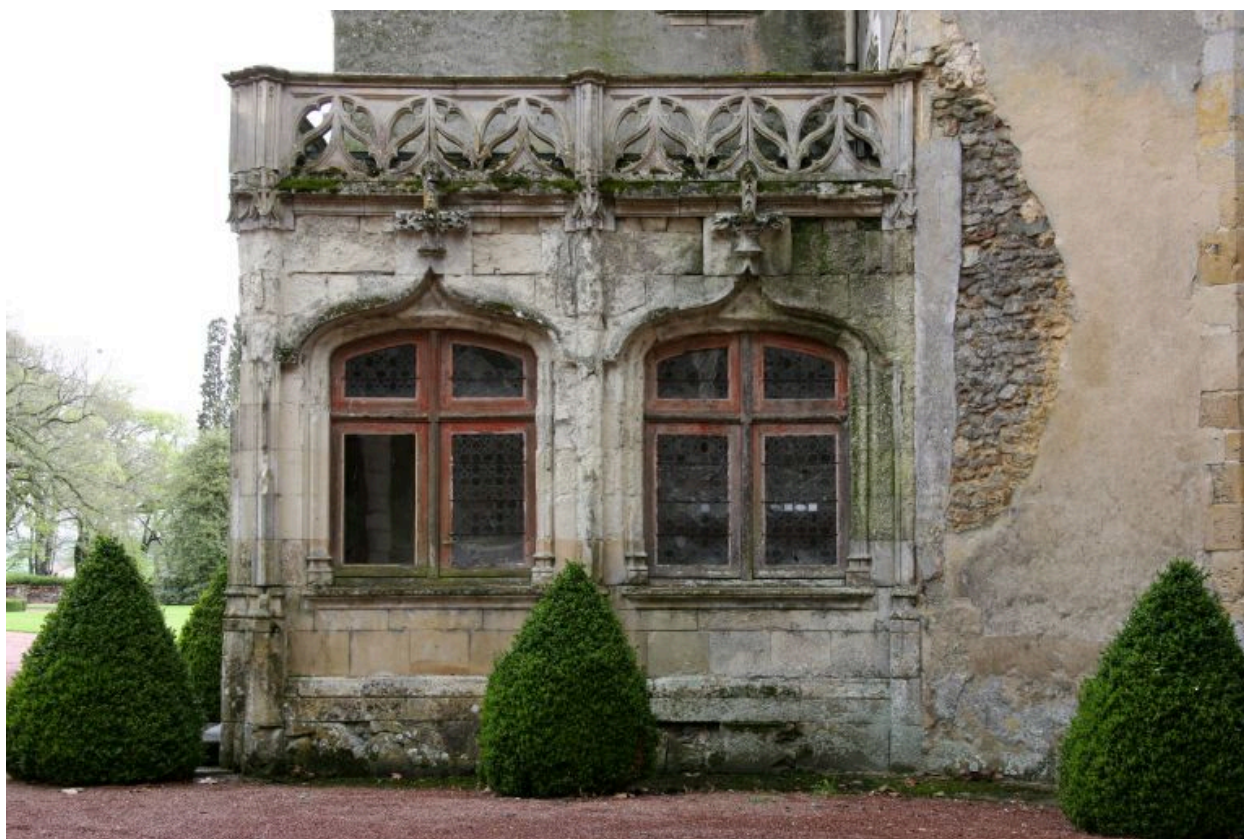
Le vestibule ajouté à la tourelle d'escalier.
