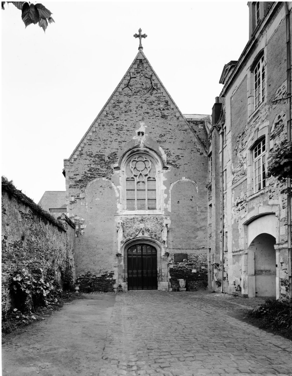
Eglise : façade antérieure (sud) et porterie : façade sur la cour d'entrée.
