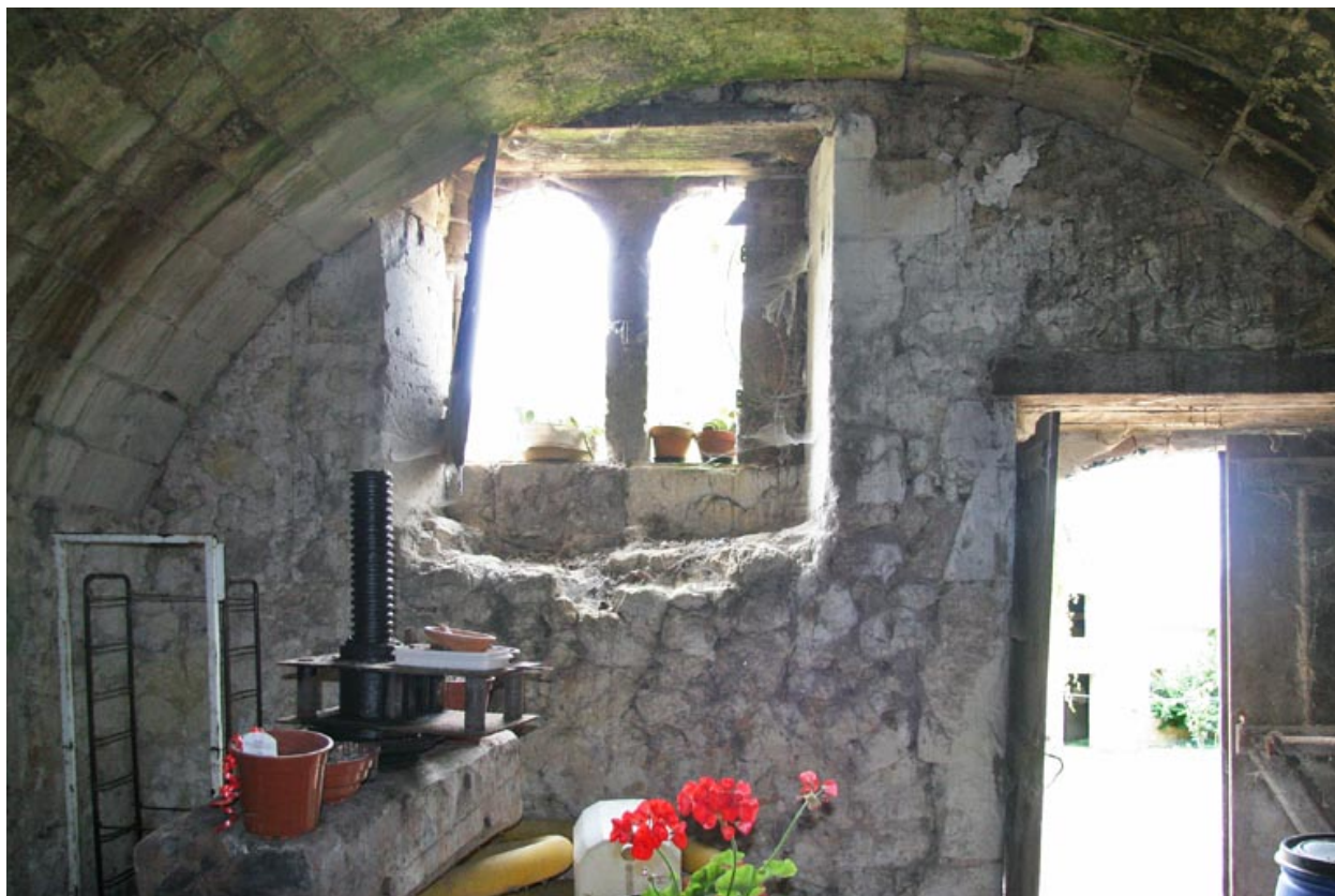
Communs, détail : fenêtres géminées (revers).
