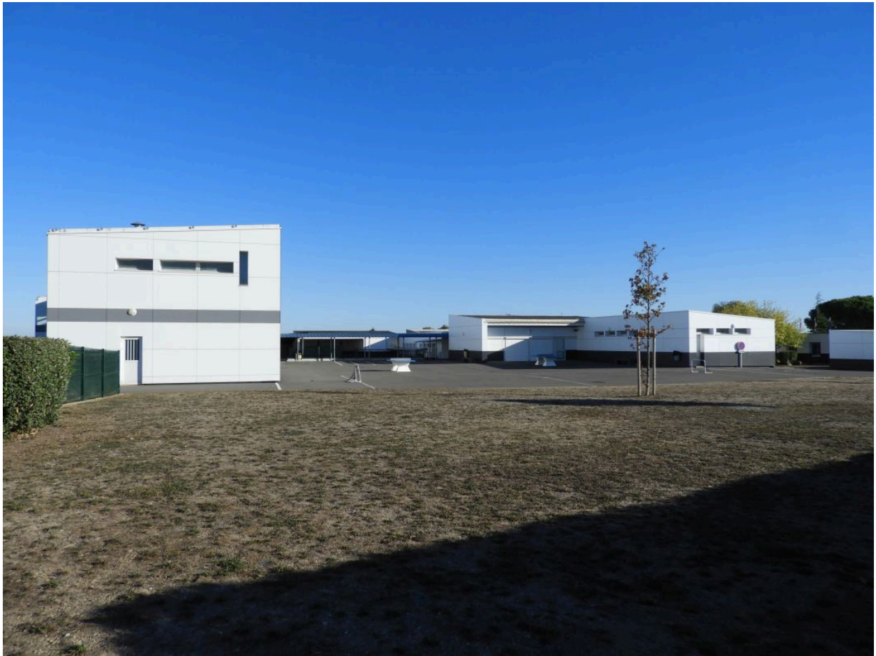
Le collège et la cour sud vus depuis le sud.
