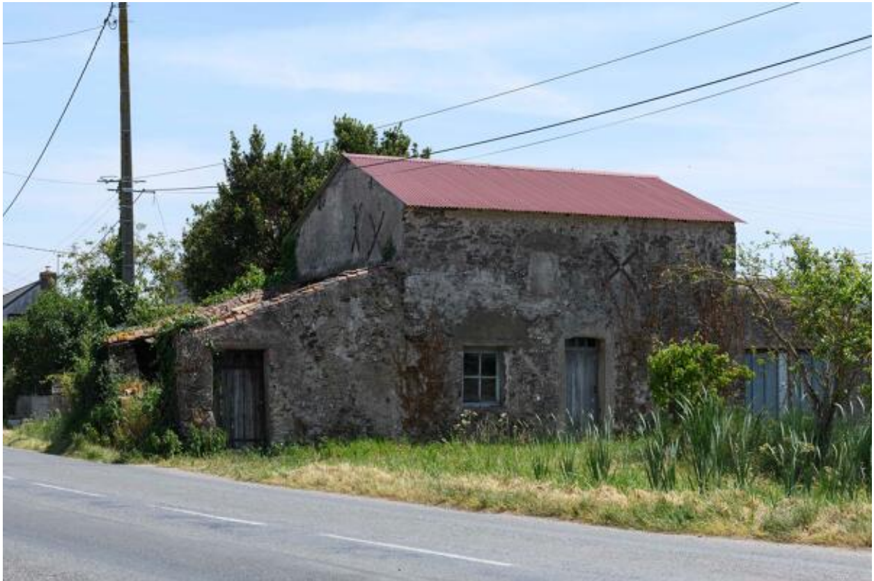
Le Dodineau. Vue d'ensemble de la ferme n° 2 depuis le nord-ouest.
