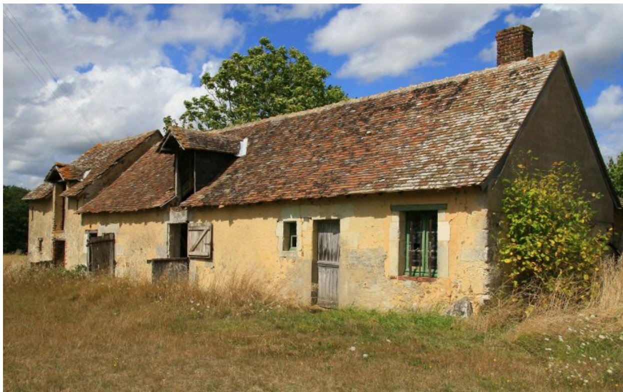
Maison n° 1 : maison et dépendances sous un même toit.
