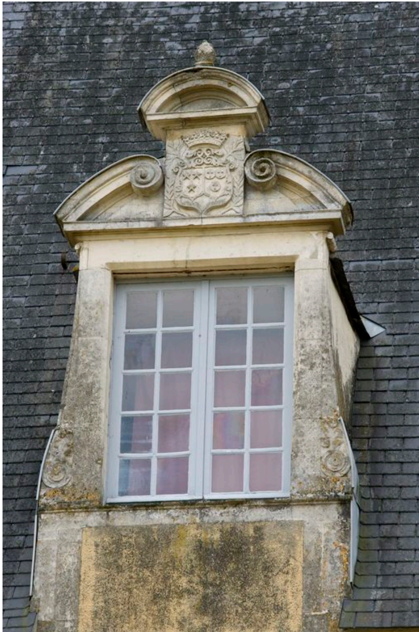
Lucarne de la travée centrale du logis.
