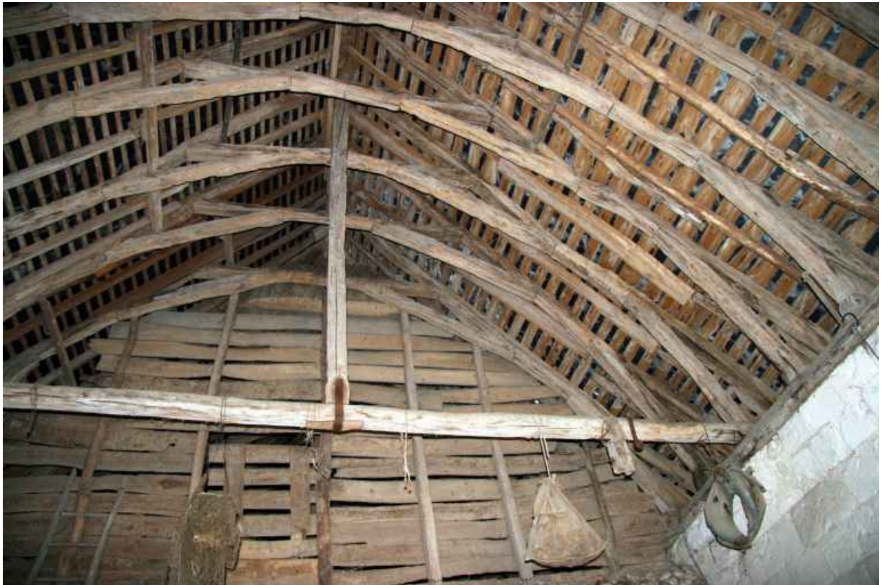
La chapelle : charpente à chevrons-portant-fermes de la nef et cloison de division.
