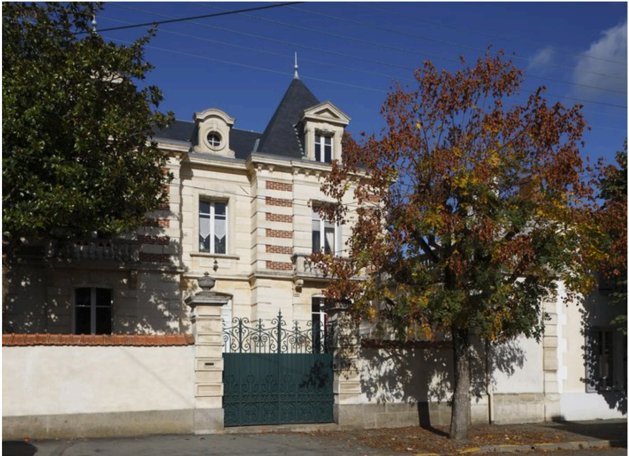
Maison 14, rue Saint-François, construite par l'entrepreneur Henri Hibert pour lui-même en 1880.
