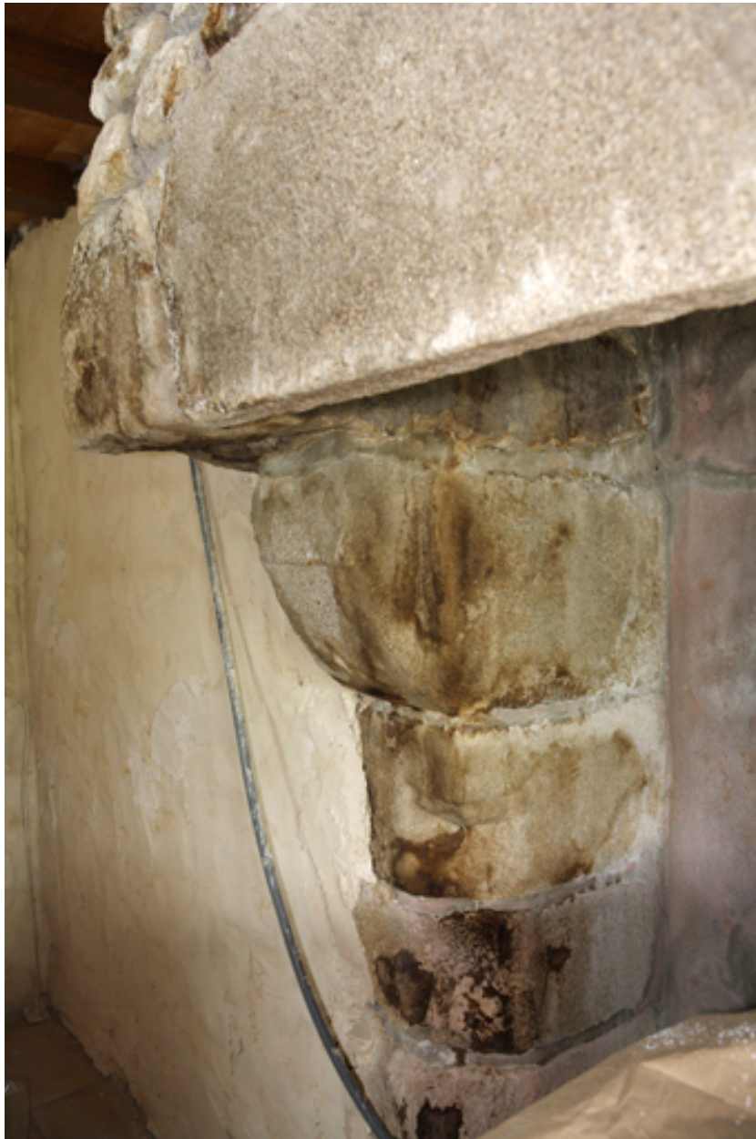
Logis. Aile sud. Détail de la cheminée sur le mur pignon sud.
