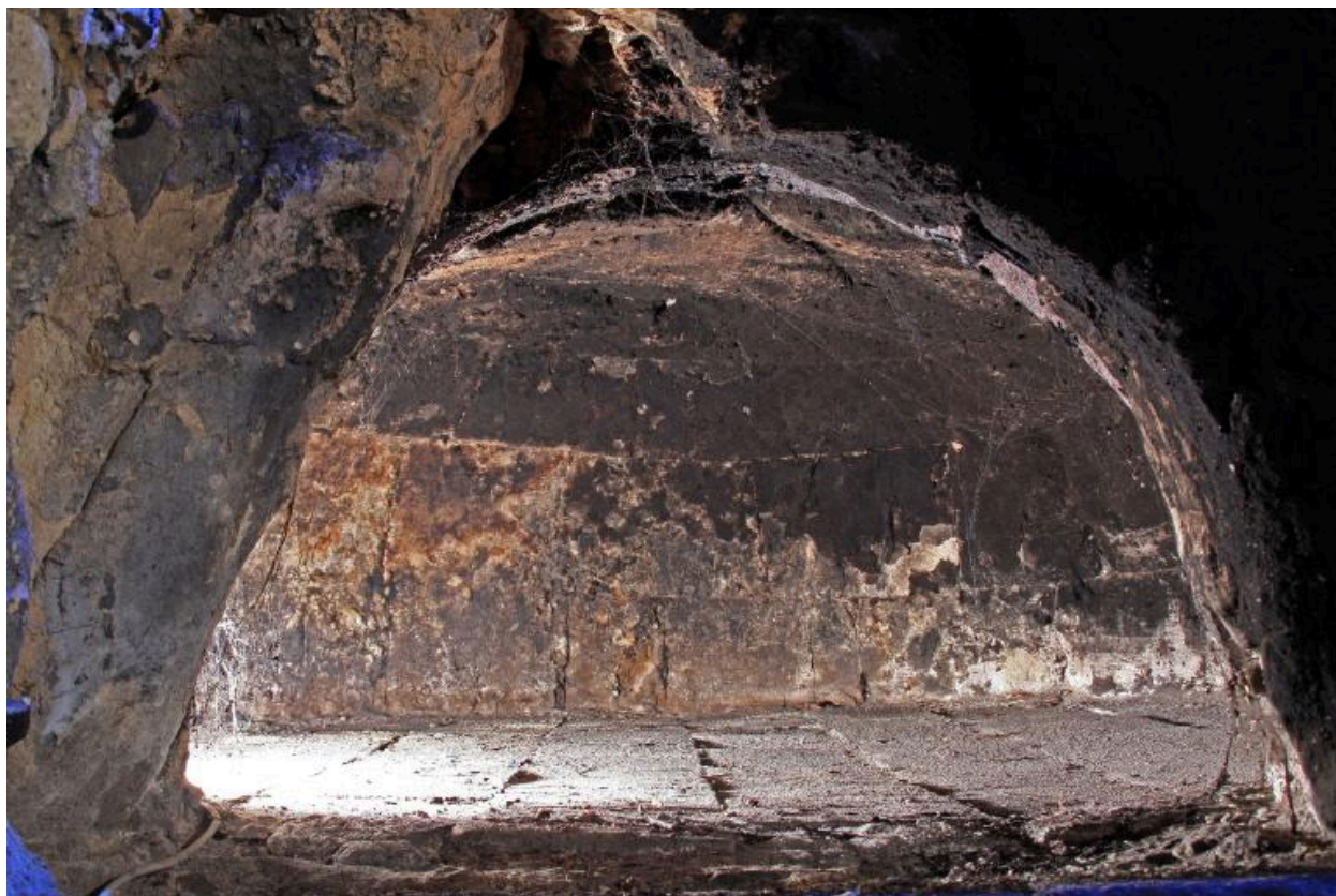
Maison ancienne : four en pierre de taille sur sol de brique.
