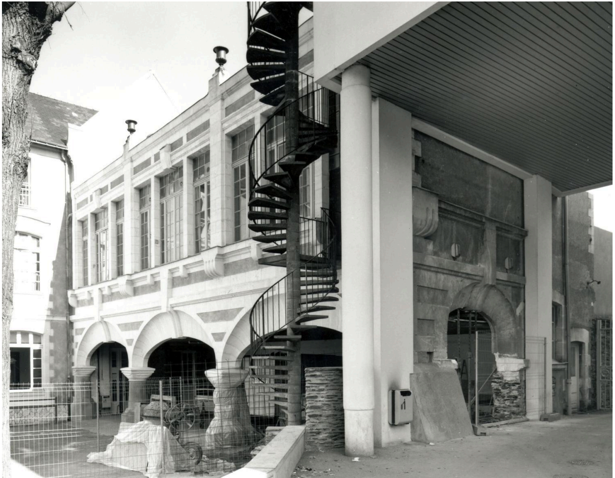
Externat Saint-Maurille, préau et salle de classe de dessin attenant au bâtiment scolaire nord : élévations antérieure et latérale droite.
