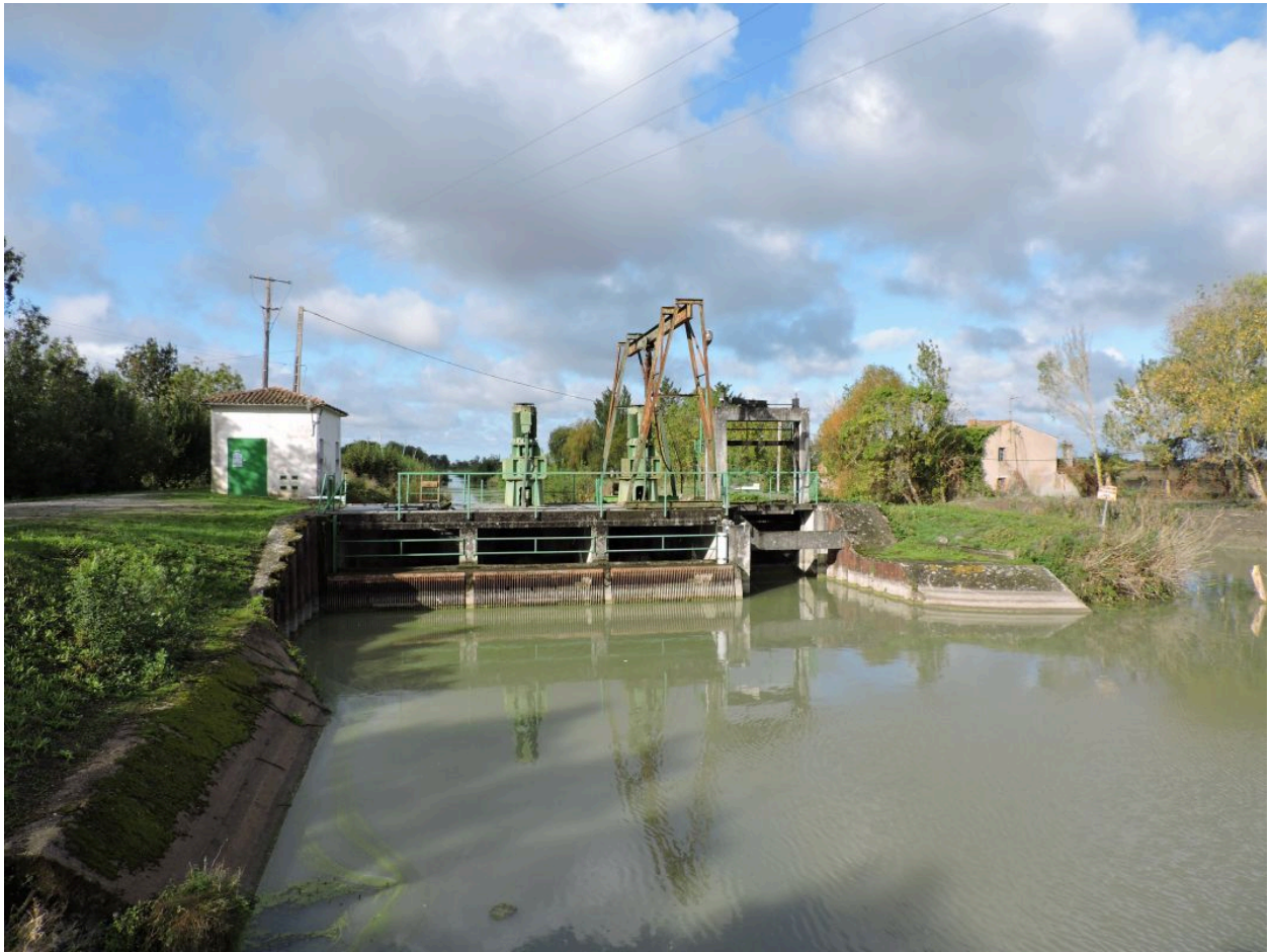
Le barrage vu depuis l'amont, à l'est.
