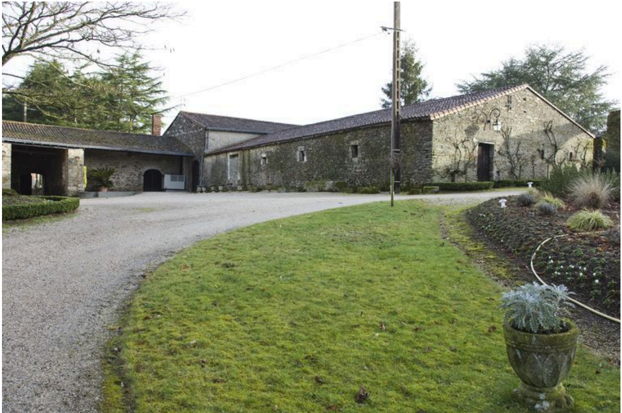
Le chai vu du sud-ouest.
