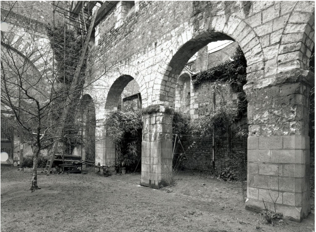
Arcades de la basse nef : vue rapprochée.
