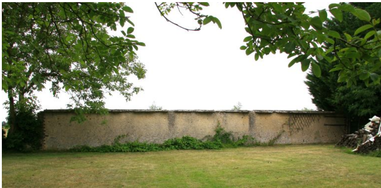
Mur de l'ancien potager ou verger.
