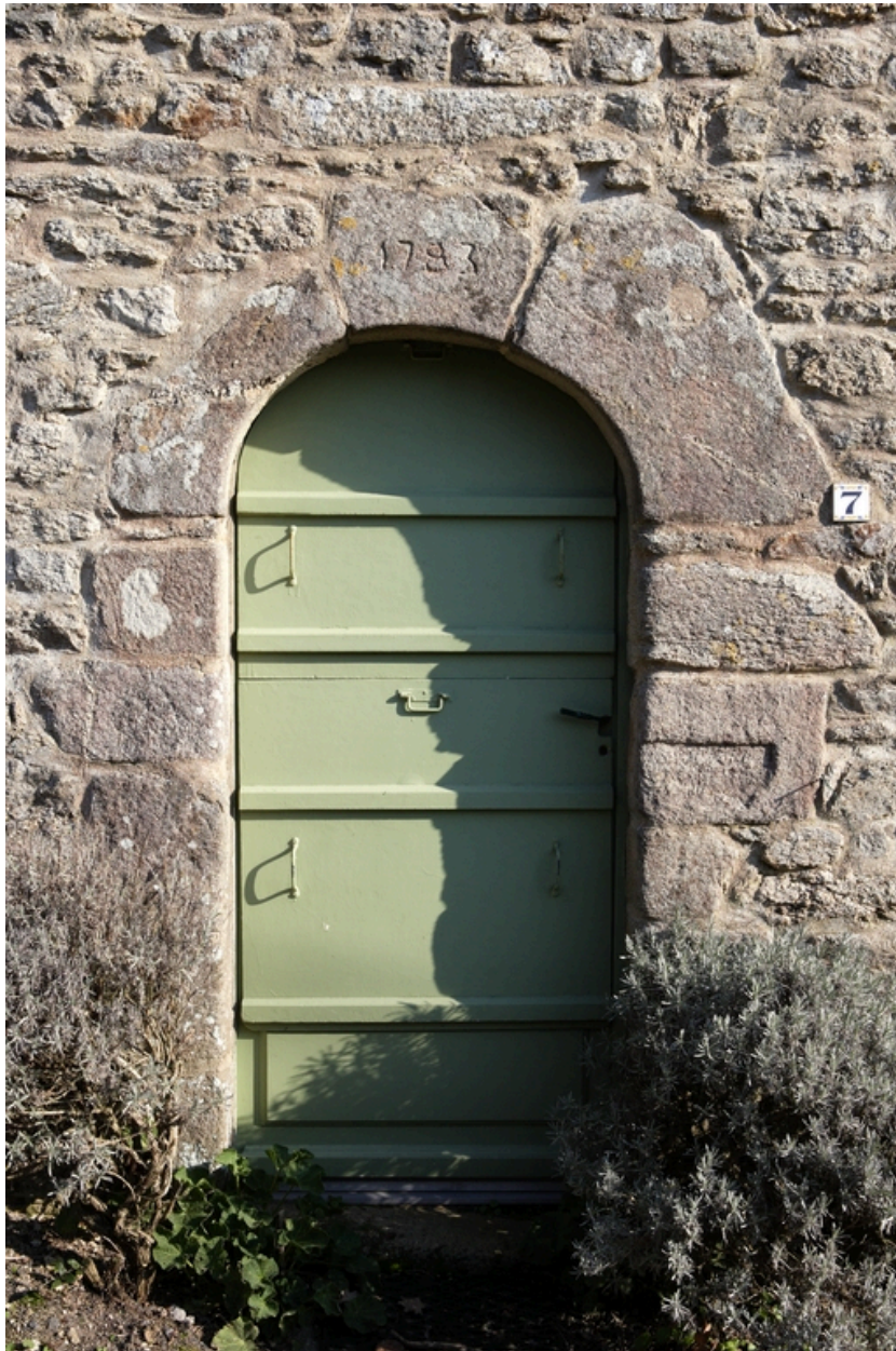
Détail de la porte d'entrée du 7 rue du Vertenay datée 1793.
