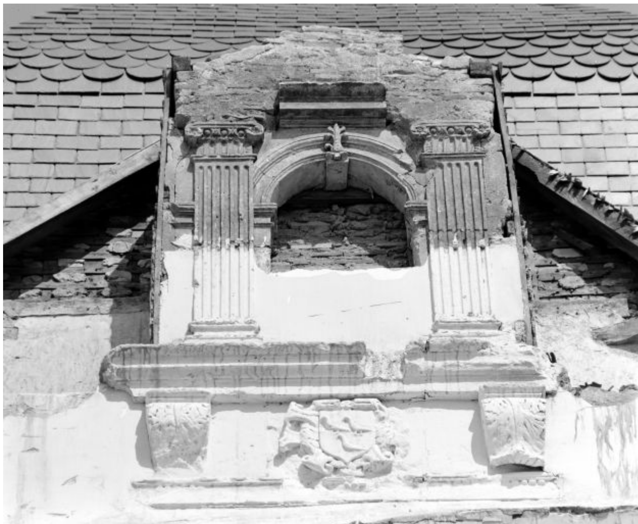
Détail d'une lucarne (avec armoiries) de l'aile sud après les travaux de 1998.
