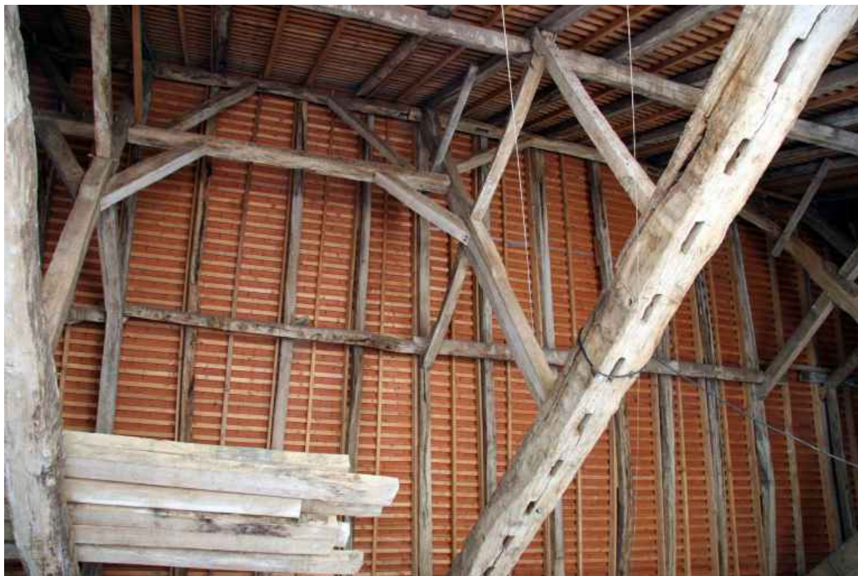
La grange : charpente à pannes avec sous faîtage.
