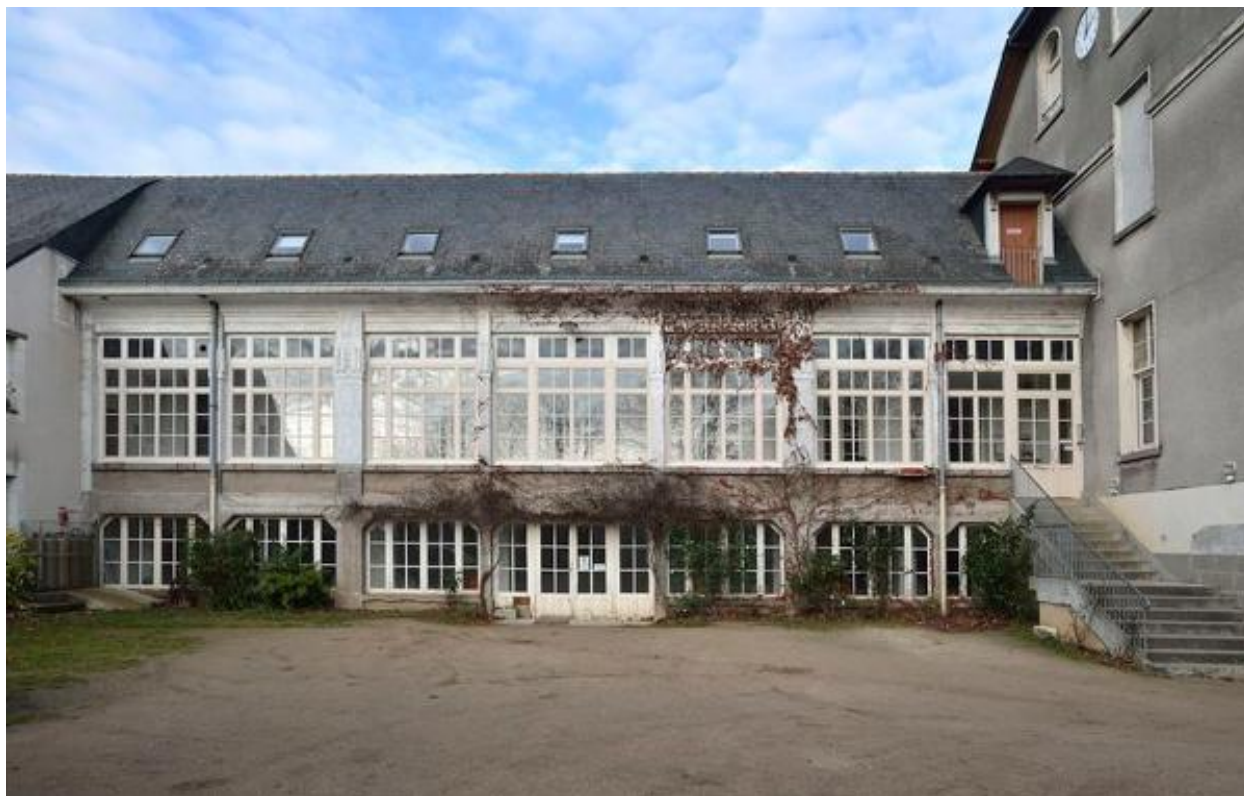
Aile gauche du bâtiment.
