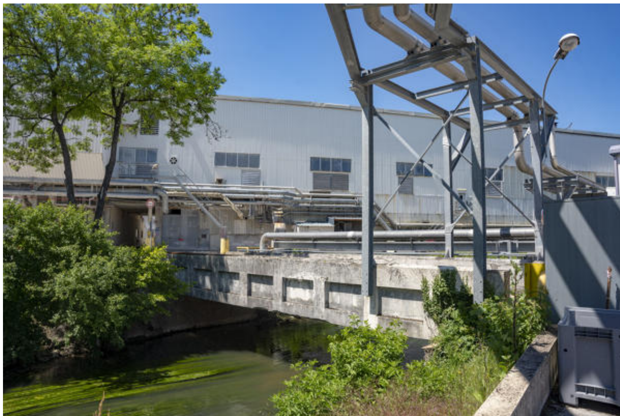
Usine de papeterie, pont en béton armé édifié en 1927 au-dessus de la Braye.
