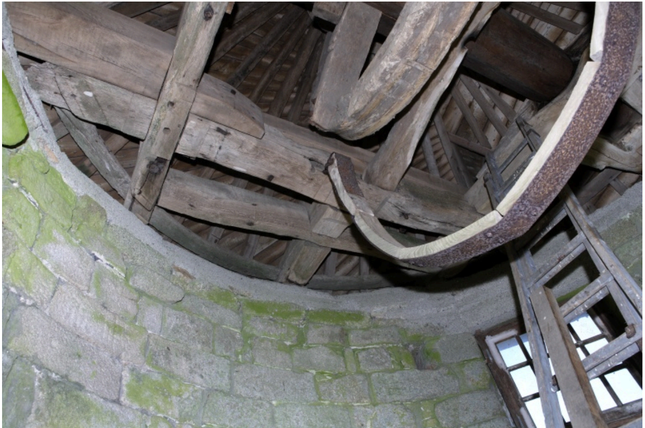
Vue intérieure de la coiffe ; l'arbre moteur, le rouet et la bande du frein.
