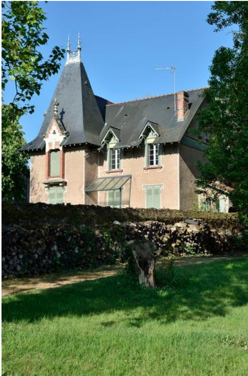
Épiré. Castel Fleuri. Vue de la façade sud.
