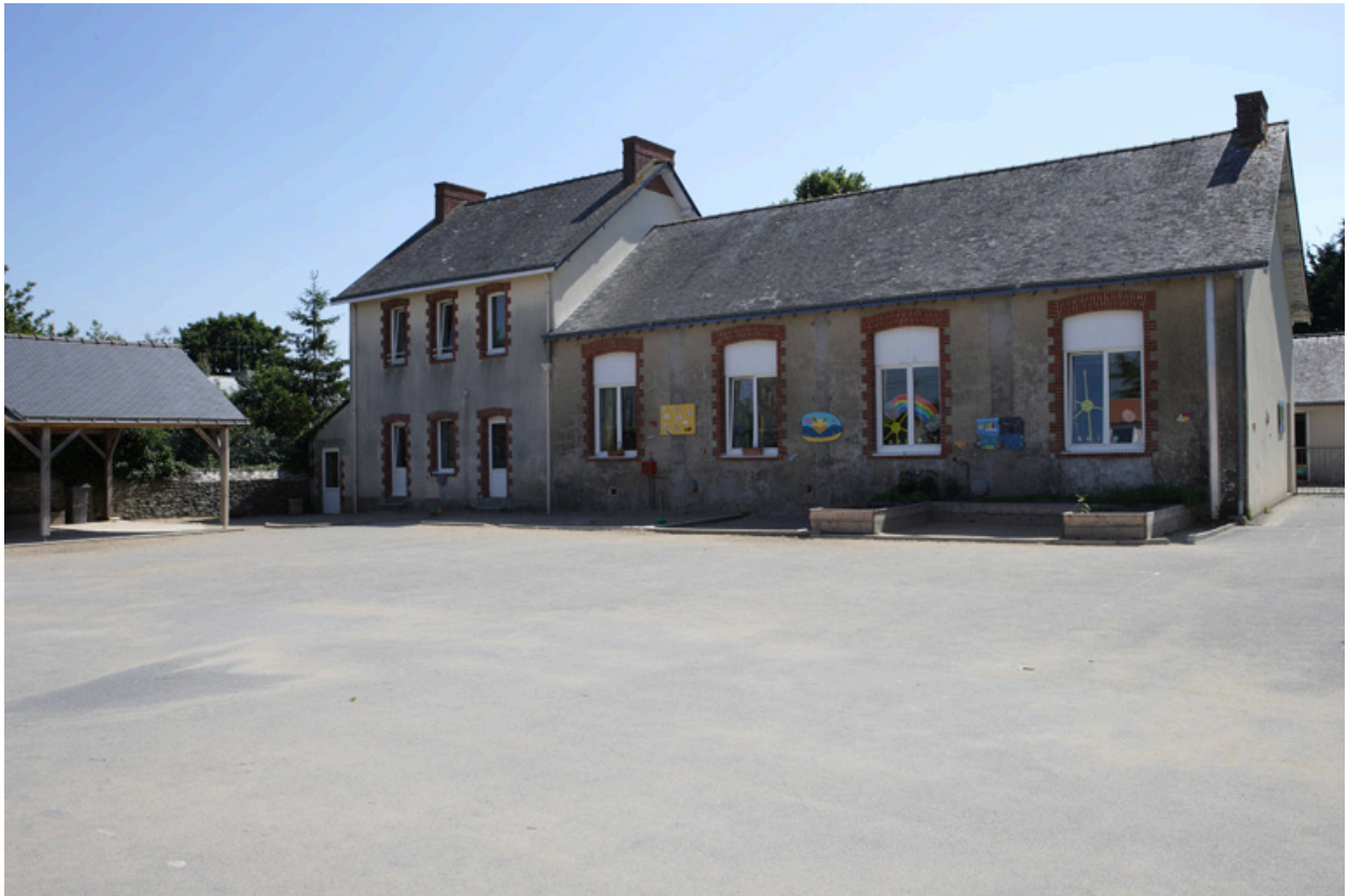
Vue de la façade arrière.
