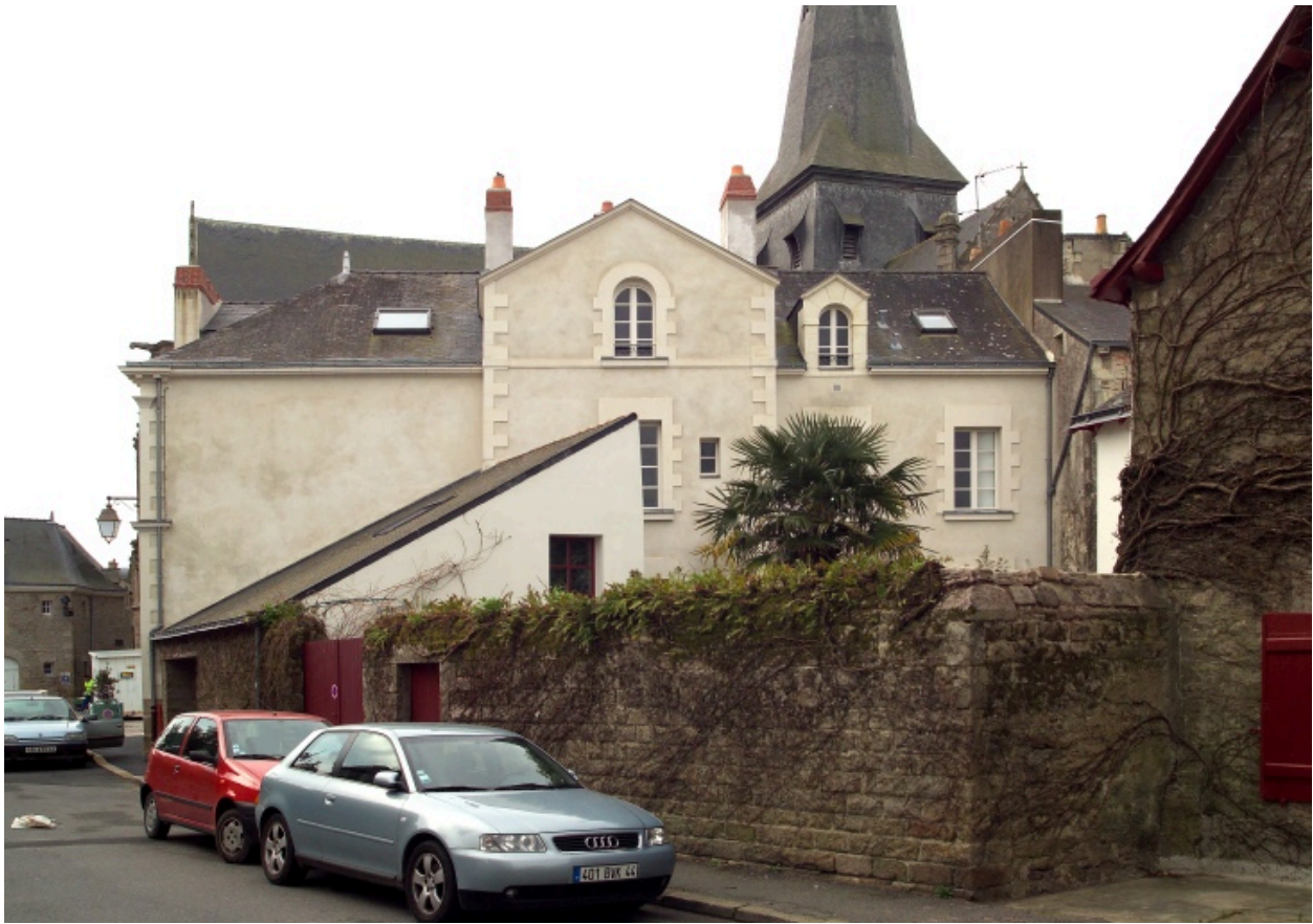
Vue de la façade postérieure.
