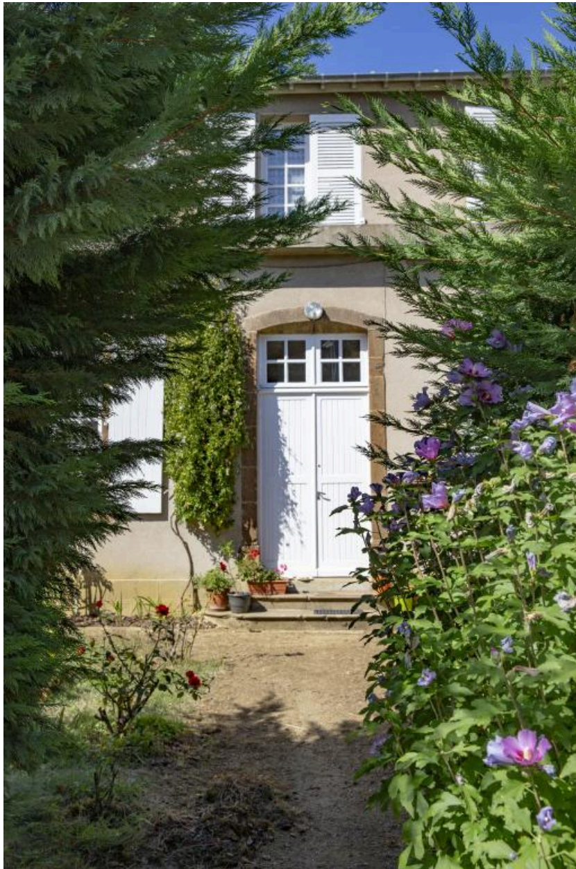
Vue du bâtiment ancien de l'école Garnier Pagès.
