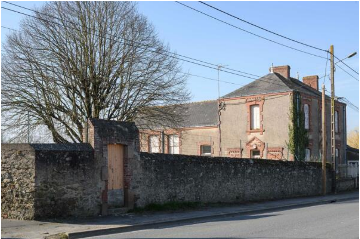
Vue d'ensemble depuis la rue de la Loire côté sud.
