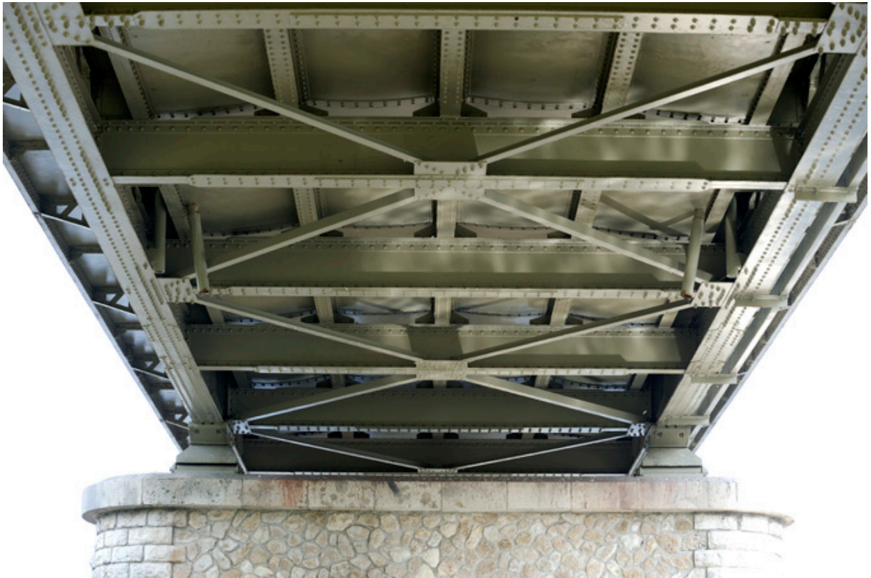
Charpente métallique soutenant le tablier (détail)
