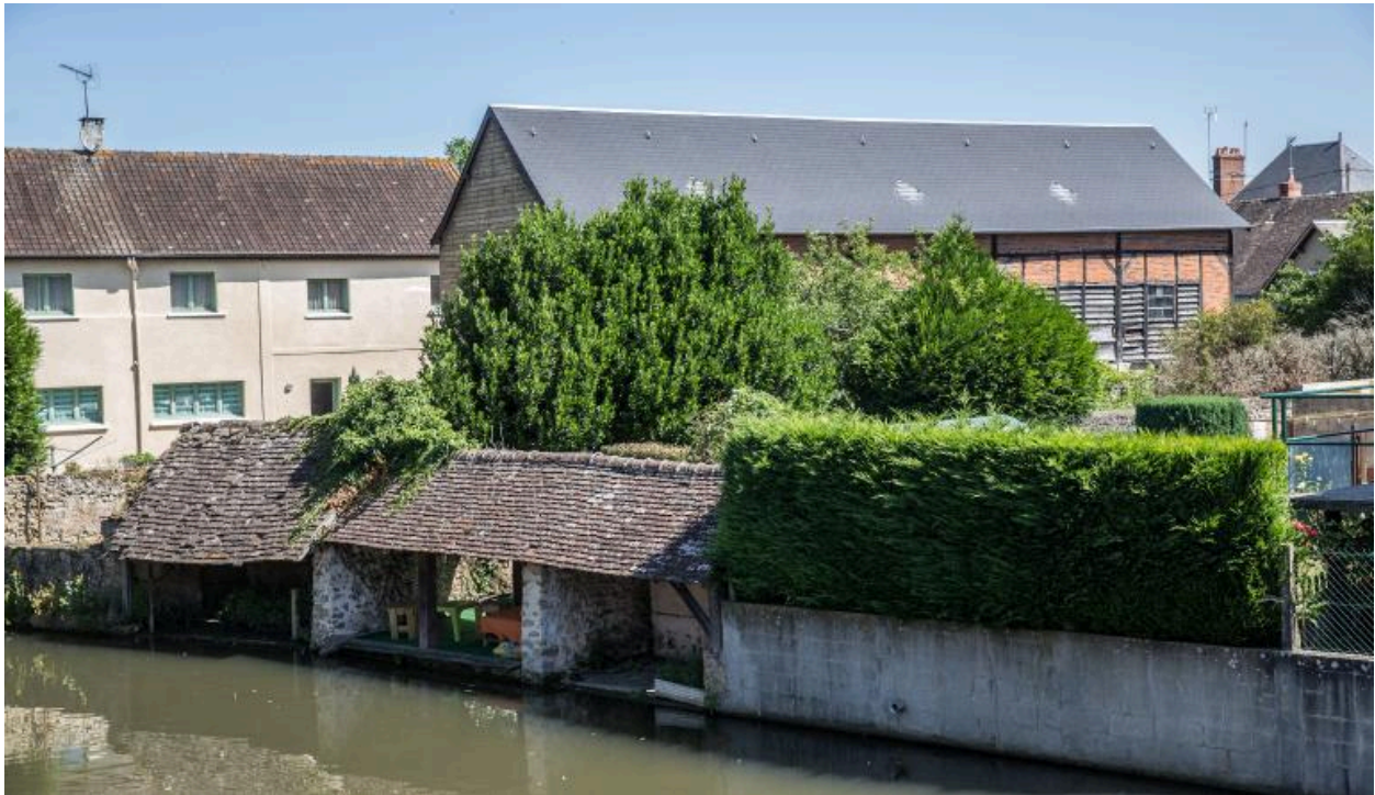
Une vue d'ensemble de la tannerie.
