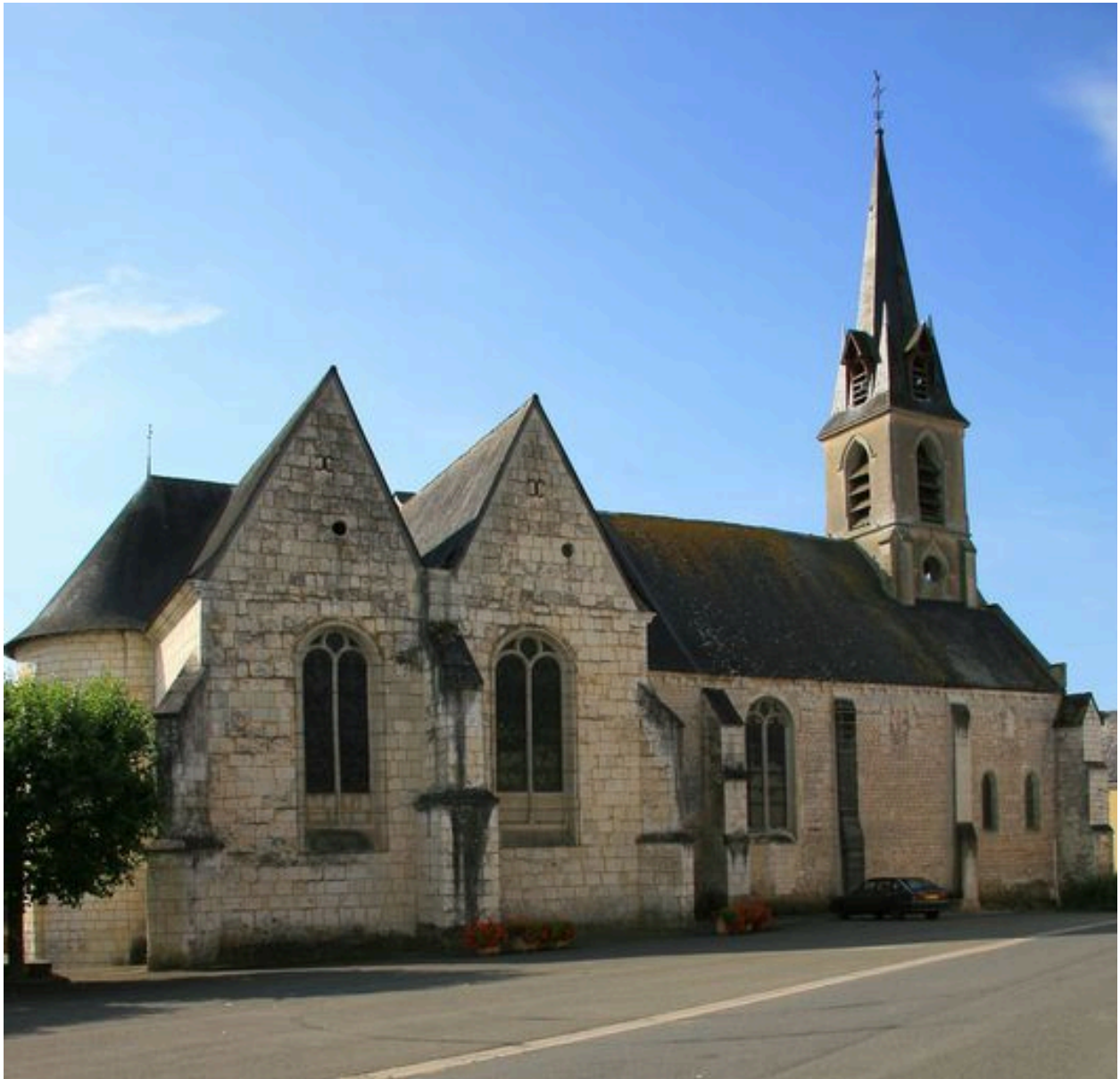
Façade nord de l'ensemble de l'édifice.
